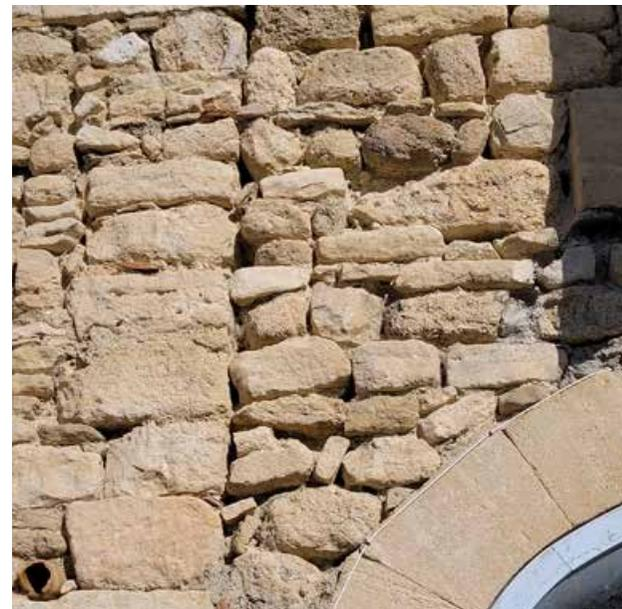
MOELLONS CALCAIRES ET MORTIER DE CHAUX ET SABLE
