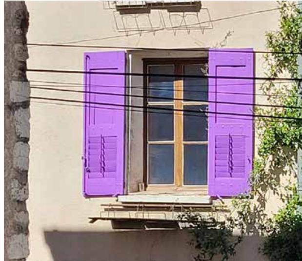
appui béton et enduit ciment non adaptés
