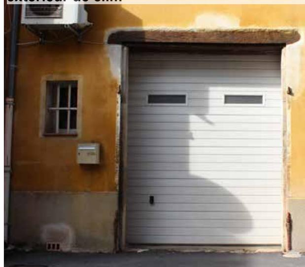
appui béton et enduit ciment non adaptés
